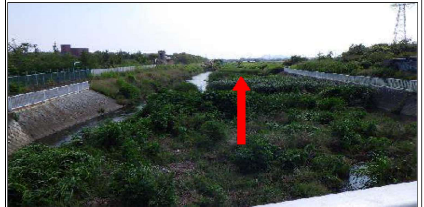
一ツ橋下流部
